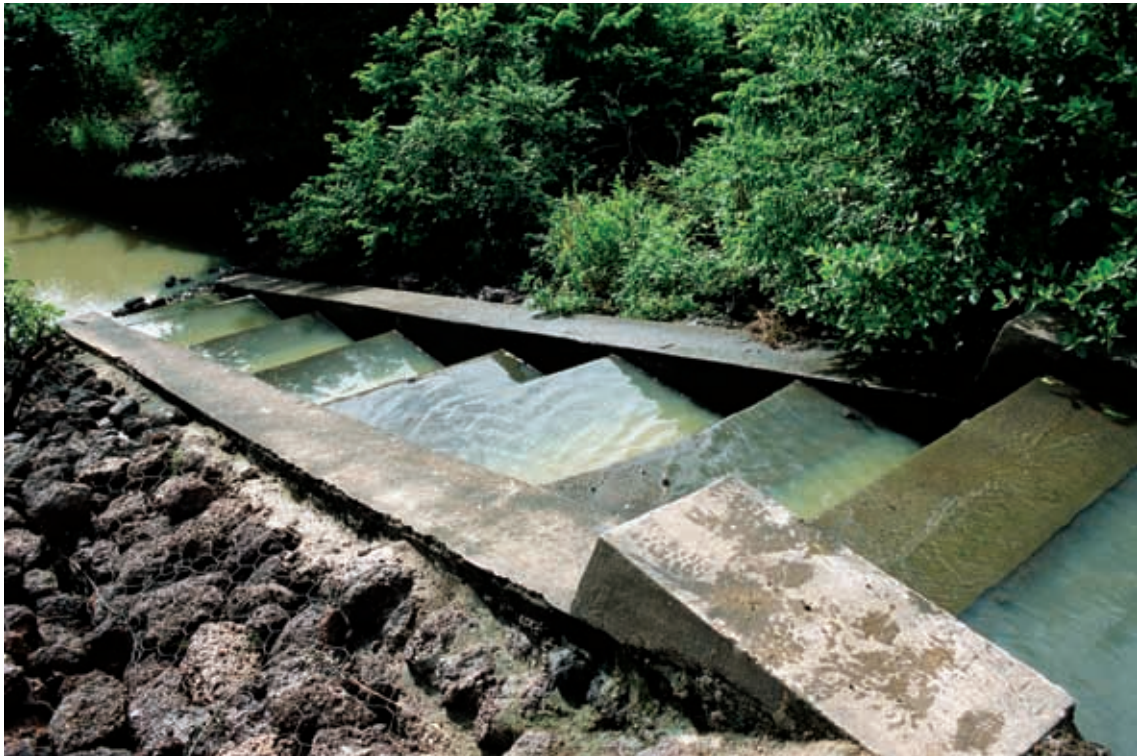
Une échelle à poissons permet aux poissons de migrer au-delà d'un barrage d'irrigation (Burkina Faso). Les échelles à poissons constituent une amélioration importante des infrastructures pouvant accompagner les lâchers de débits environnementaux. © Reinout van den Bergh/Hollandse Hoogte
